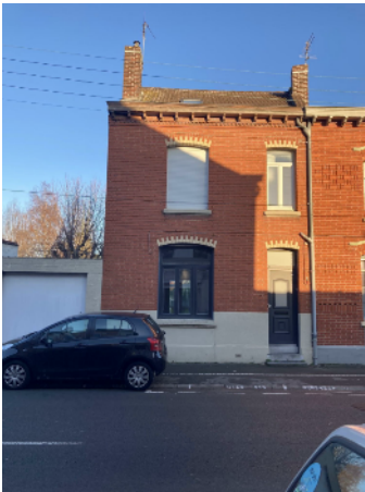
Façade côté rue en brique
