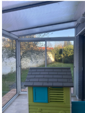
Véranda non chauffée
