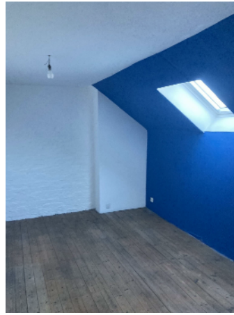
Rampants de plafonds des combles aménagés en plâtre sans isolation Velux bois anciens en double vitrage
