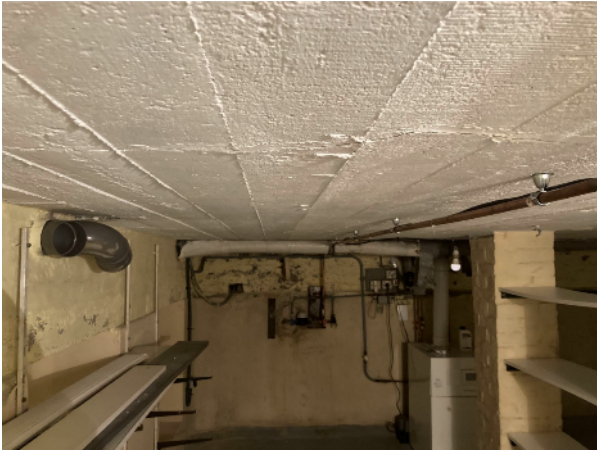
Plancher bas sur cave en béton non isolé
