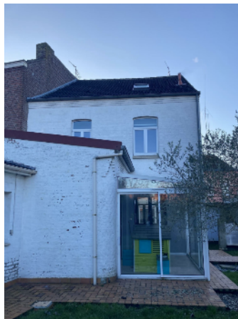
Façade côté jardin avec véranda non chauffée et extension. Murs en brique de terre cuite et toiture en bac acier
