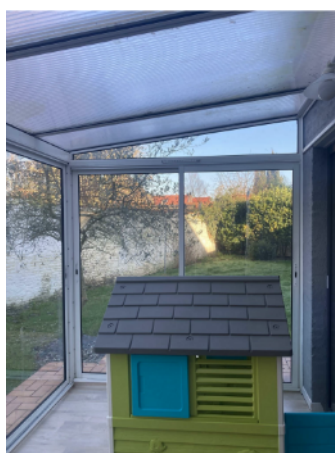
Véranda non chauffée avec menuiseries anciennes double vitrage et toiture polycarbonate. Profils alu.
