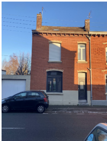
Façade côté rue en bon état avec brique terre cuite et toiture tuiles béton
