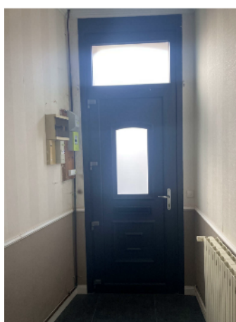
Porte d'entrée PVC isolante récente avec imposte en double vitrage Étanche à l'air
